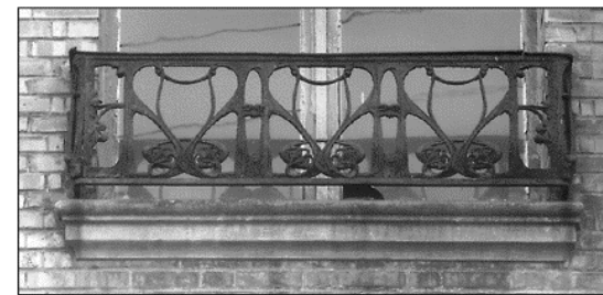
Garde corps de fenêtre et de balcon en ferronnerie composés à partir d'éléments figurant au catalogue des fonderies de Saint Dizier [Pl 10, catalogue des fontes artistiques, dessin de Hector Guimard (dessin réalisé pour les ferronneries de l'hôtel Mezzara)].
