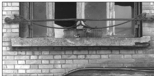
Garde corps de fenêtre et de balcon en ferronnerie composés à partir d'éléments figurant au catalogue des fonderies de Saint Dizier [Pl 10, catalogue des fontes artistiques, dessin de Hector Guimard (dessin réalisé pour les ferronneries de l'hôtel Mezzara)].
