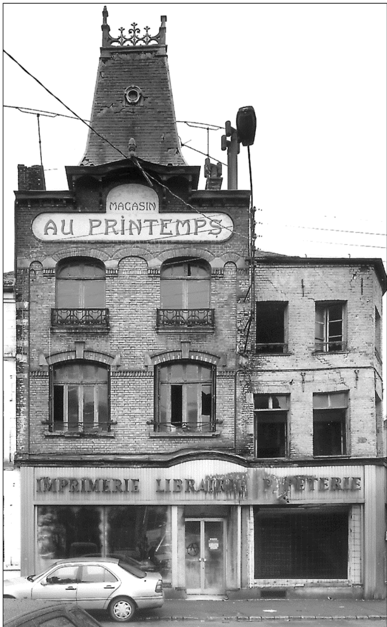
Rez de Chaussée à usage commercial : il a été entièrement dénaturé par les derniers propriétaires avant que l'ensemble du bâtiment ne soit laissé progressivement à l'abandon. Jeu de brique en façade (polychromie et bandeau de briques disposées en oblique).
